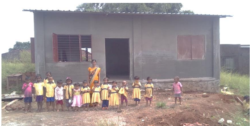
Neues Zentrum in Kasara
